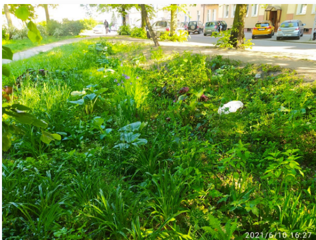
Ogród deszczowy w gruncie w Gdańsku. Ogrody deszczowe w gruncie w odpowiednich warunkach poza funkcją retencyjną mogą także infiltrować wody opadowe.
