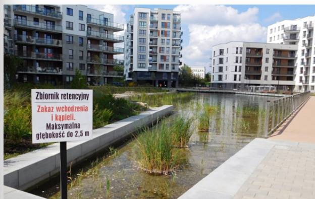
Zbiornik retencyjny na terenie osiedla mieszkaniowego w Warszawie. Stanowi istotny element systemu zagospodarowania wody opadowej wraz z zielonym dachem i zbiornikami retencyjnymi podziemnymi. Za jakość wody w zbiorniku odpowiada roślinna strefa regeneracyjna oraz filtry mineralne.
