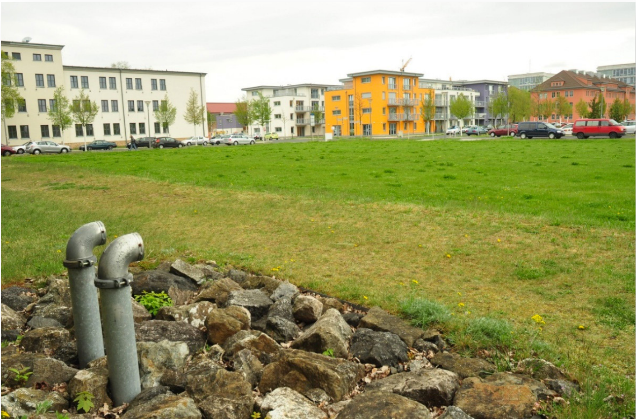
Zbiornik „suchy” – okolice Berlina. Zatrzymuje i infiltrowuje wodę opadową tylko w przypadku intensywnych opadów. Na co dzień pełni funkcję terenu zielonego i boiska.
