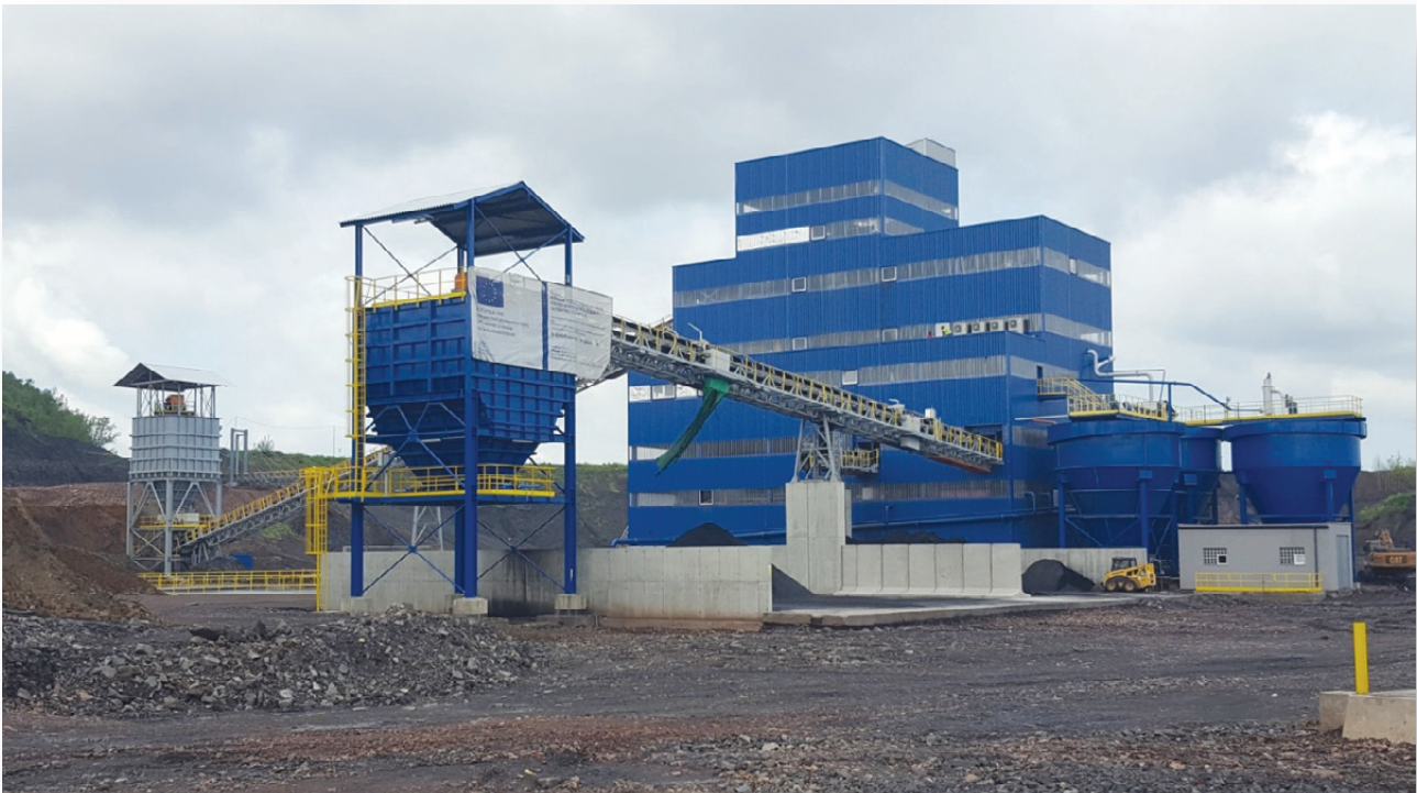
Hermanicka Halda - budynek zakładu wzbogacania odpadów z hałdy
